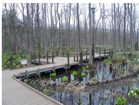
札幌手稲区 星置緑地木道再整備工事
