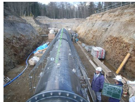
旭川土現 パイプライン改修施工監理
