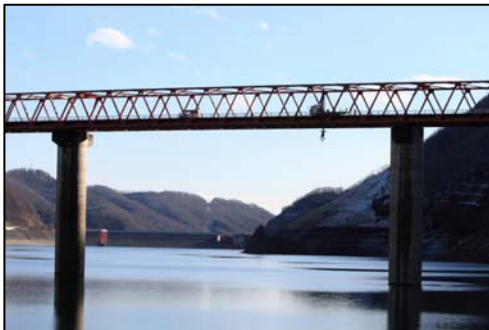
トラス橋下面の点検
