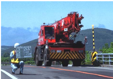
Step1 ラフタークレーンによる载荷試験
