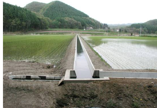
胆振支庁 用排水路
