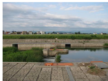
旭川土木現業所 取水堰および魚道
